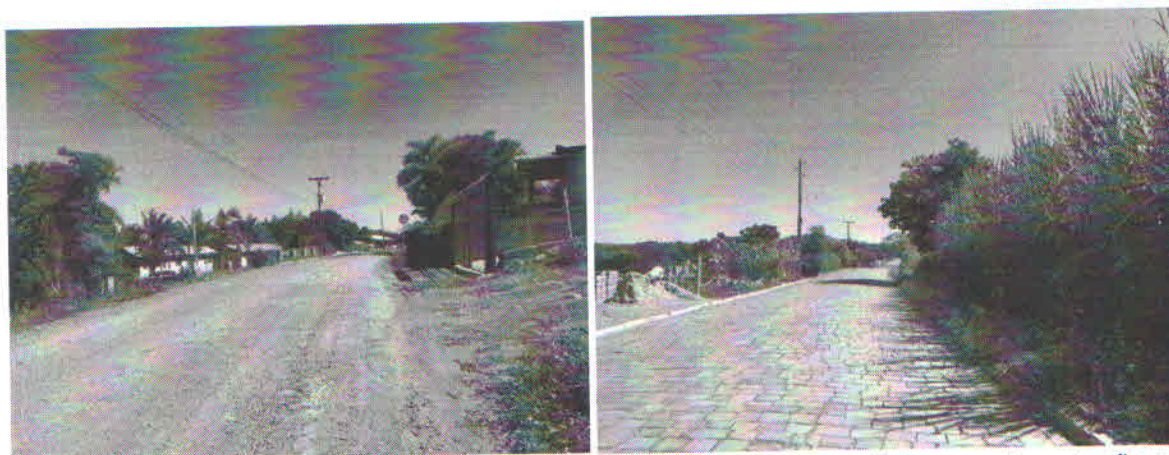
Foto 02 e 03 – Vista das área que serão expandidas, onde parte já tem pavimentação e a outra ainda não.
